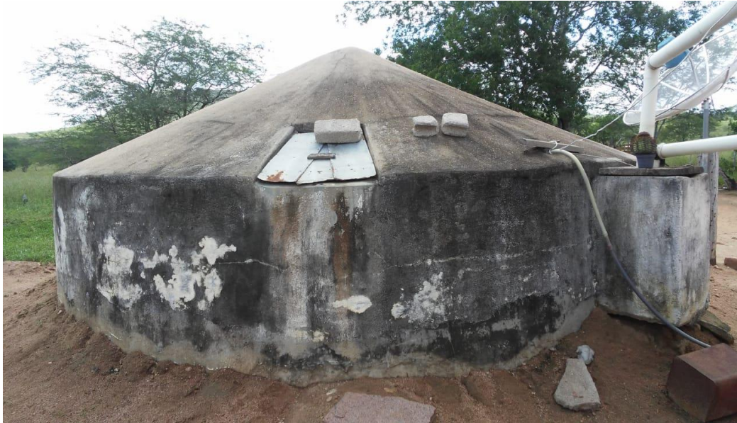
Figura 4 - Cisternas implantadas nos terrenos da Faixa
