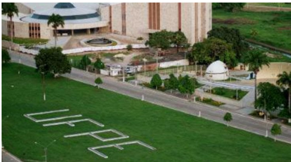
Figura 6 - Visão parcial da Universidade Federal de Pernambuco (UFPE)
